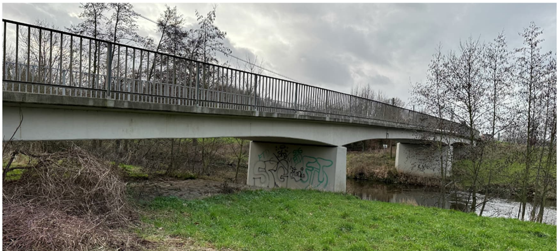
Foto 1: Brücke Körrenziger Weg - Ansicht
