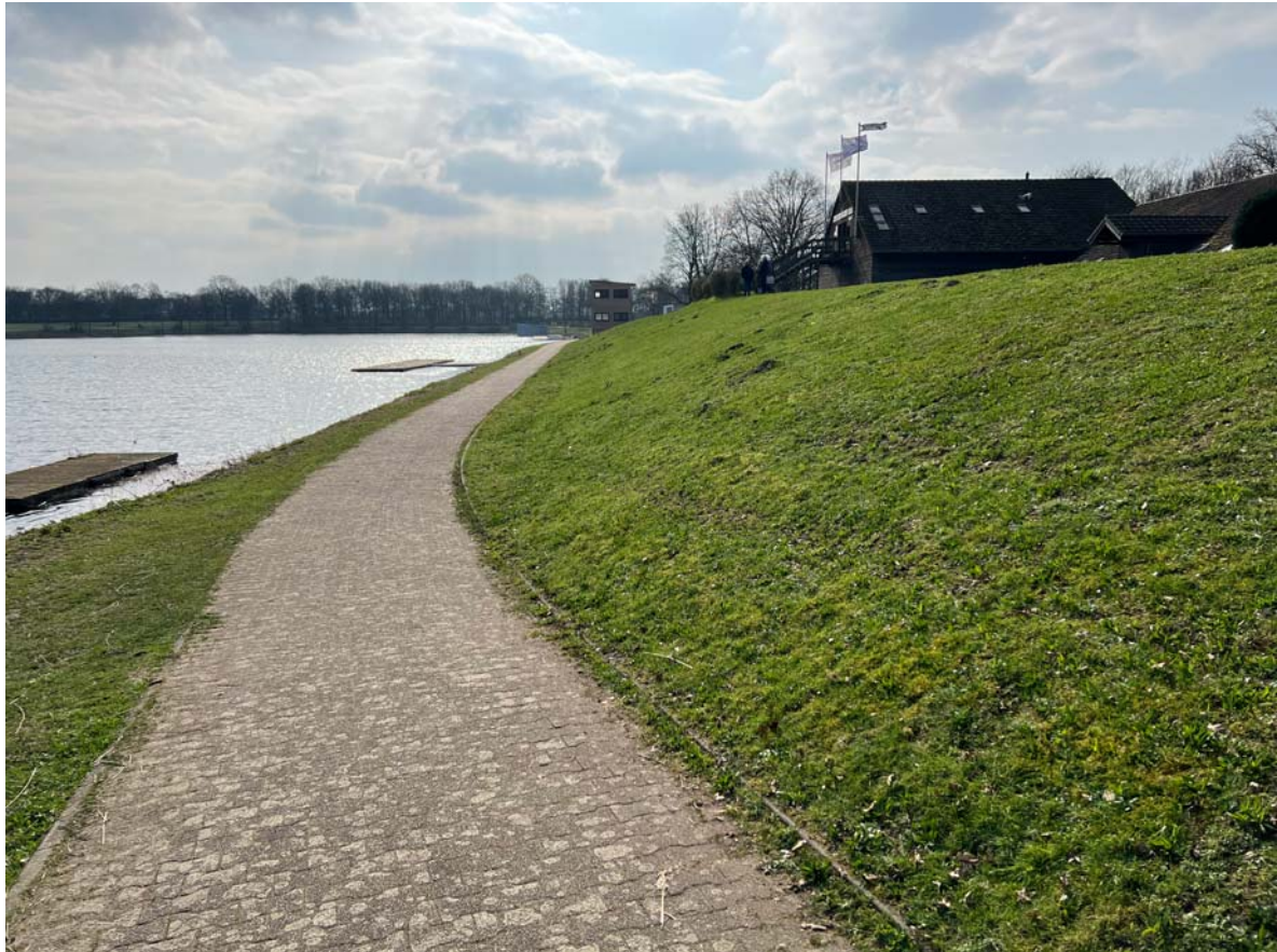
Uferweg und Böschungskörper, Blick von Norden
