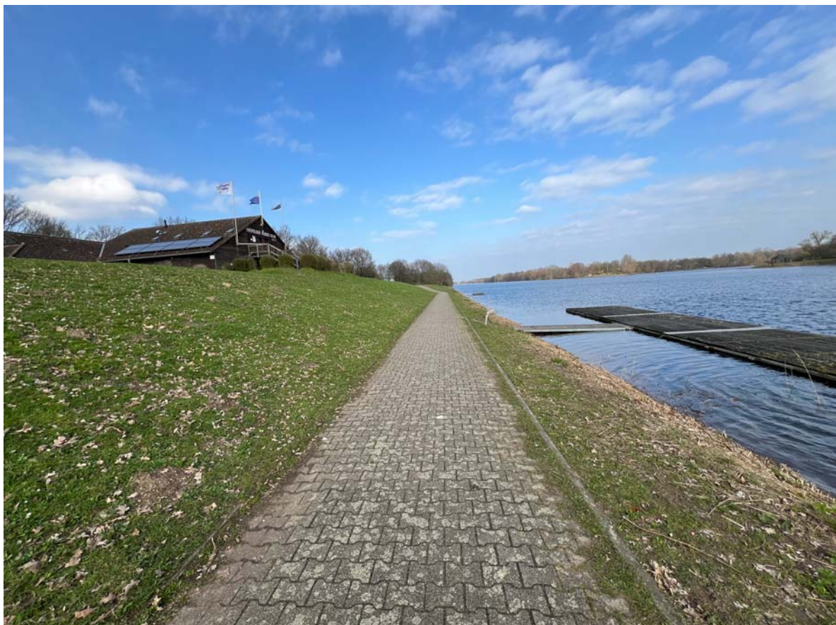
Uferweg und Böschungskörper, Blick von Süden, rechts der Steg
