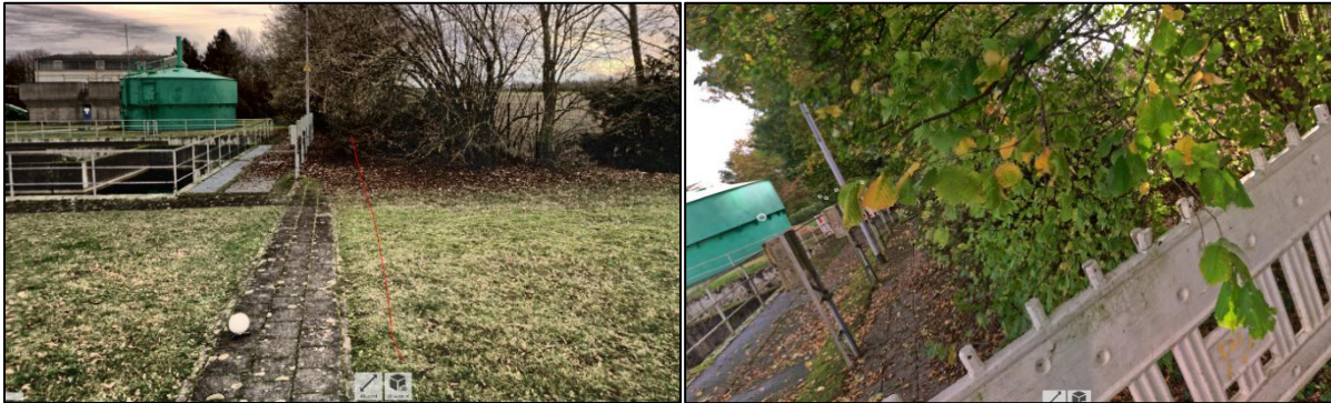
Abbildung 112: Trasse Kabelgraben von K3 zu K4
