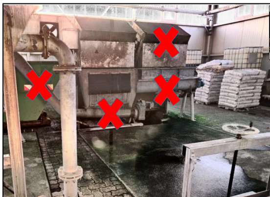
Abbildung 64: Demontage Grobrechen 1
