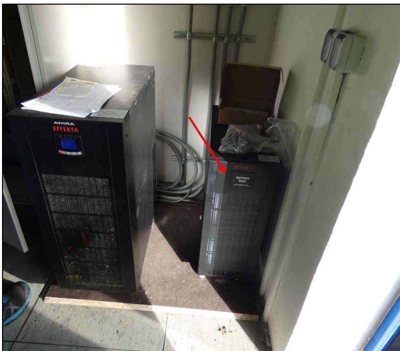
Abbildung 37: USV-Anlage
