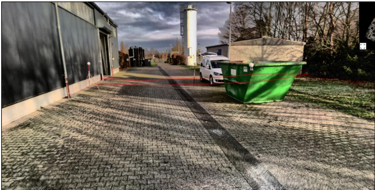
Abbildung 109: Trasse Kabelgraben von Raumzelle zur Rechenhalle
