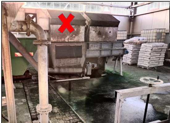
Abbildung 62: Demontage Grobrechen 2
