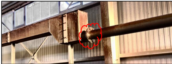
Abbildung 54: Schnittstelle Ablaufrinne im EG Rechengebäude
