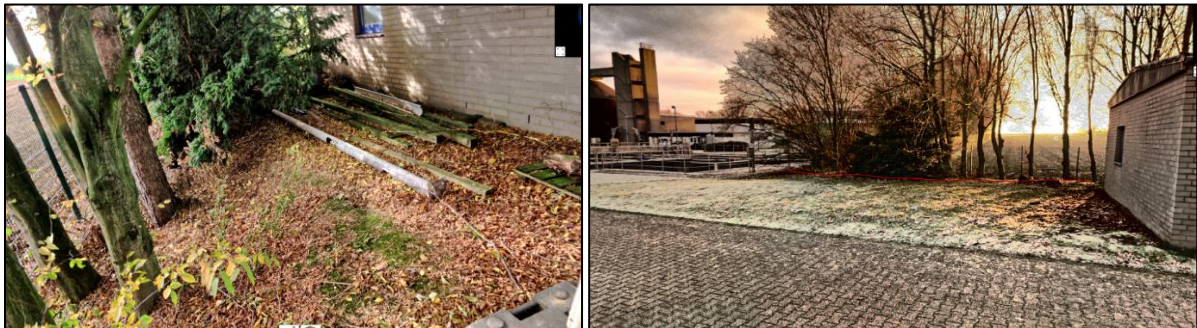
Abbildung 111: Trasse Kabelgraben von K1 zu K2
