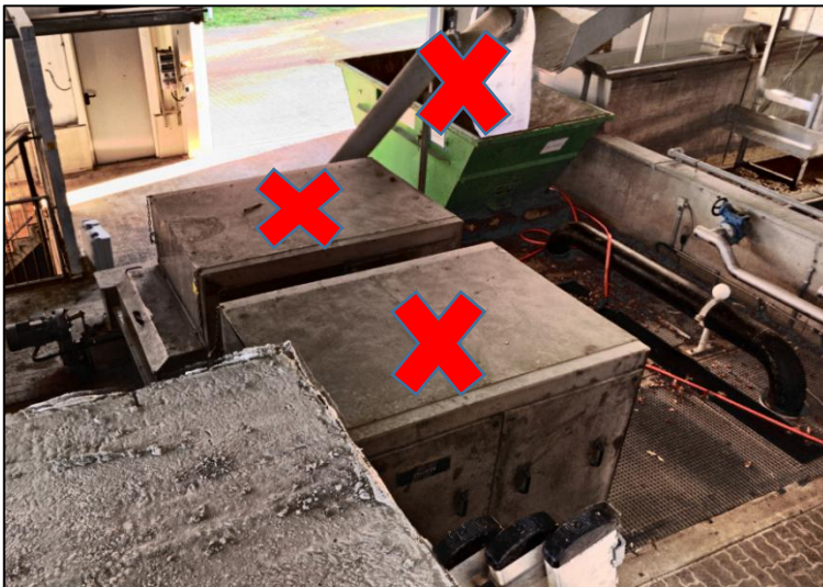
Abbildung 66: Rückbau Feinrechen
