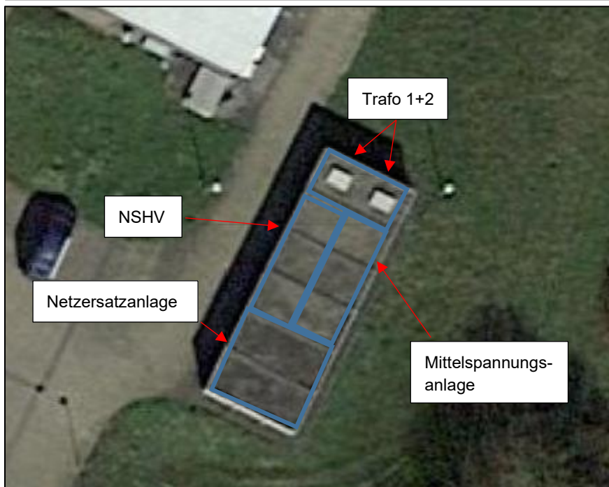
Abbildung 34: Energiestation KA Bettendorf
