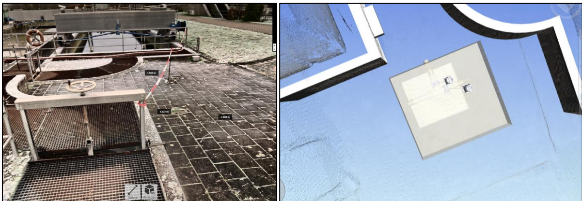
Abbildung 93: Lage der Schieber, Bereich Vorklärung
