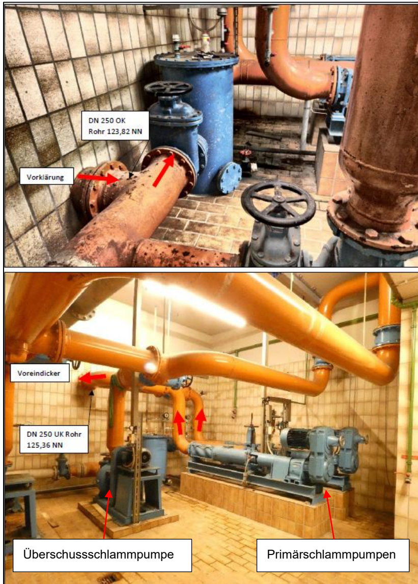
Abbildung 27: Primärschlammumpen
