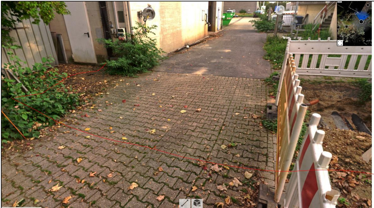
Abbildung 118: Trasse Kabelgraben von Raumzelle zur Rechenhalle
