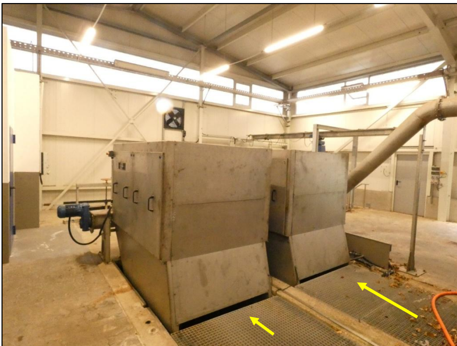
Abbildung 8: Feinrechenanlage Vorderansicht
