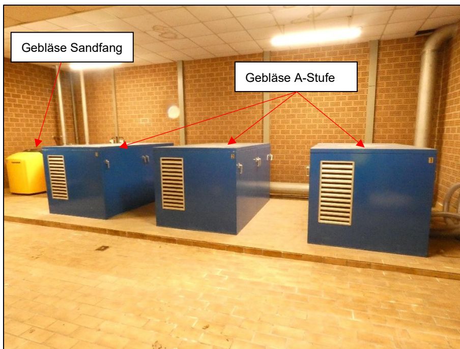
Abbildung 12: Gebläse im Gebläseraum (UG)
