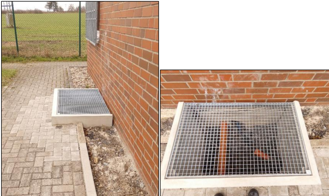
Abbildung 127: Beispiel Gebäudeeintrittspunkte mit Stahlbetonlichtschacht
