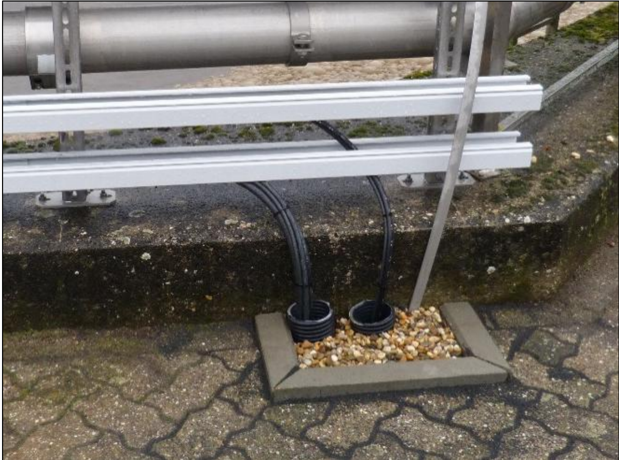
Abbildung 128: Beispiel Gebäudeeintrittspunkte mit Bordsteinumfassung
