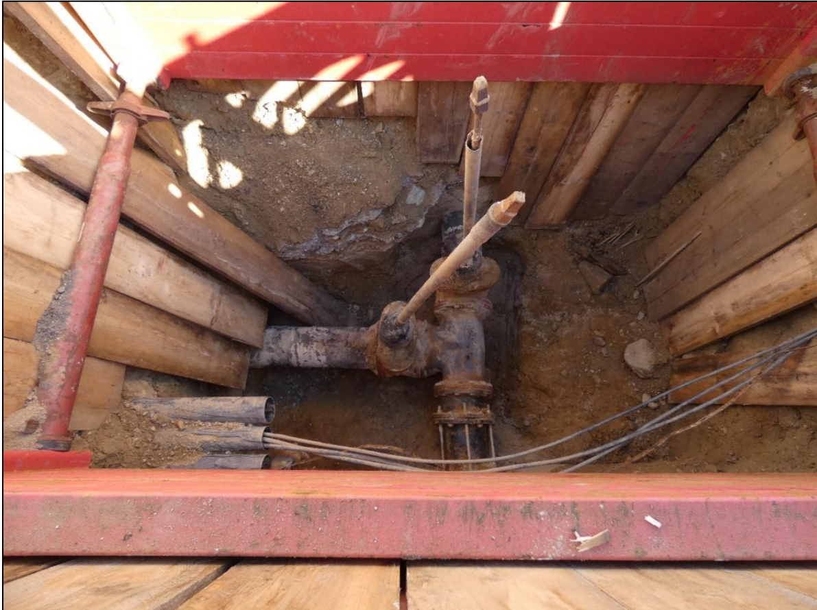
Abbildung 94: Suchschachtung 2021, auszutauschende Schieber
