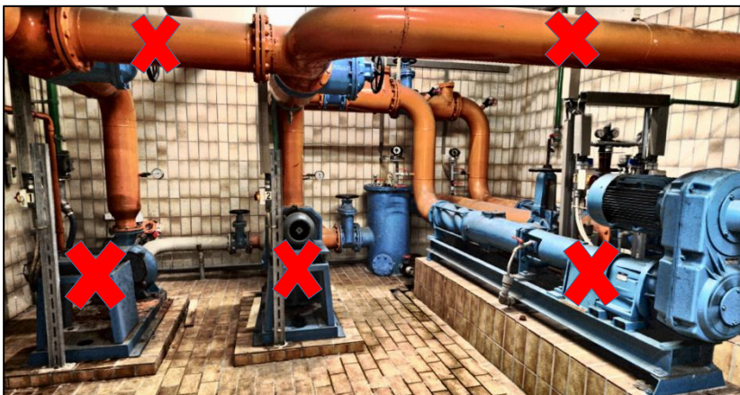
Abbildung 61: Demontage im Pumpenraum
