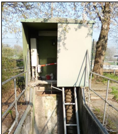
Abbildung 44: Schaltschrank Zulaufpumpwerk RÜB
