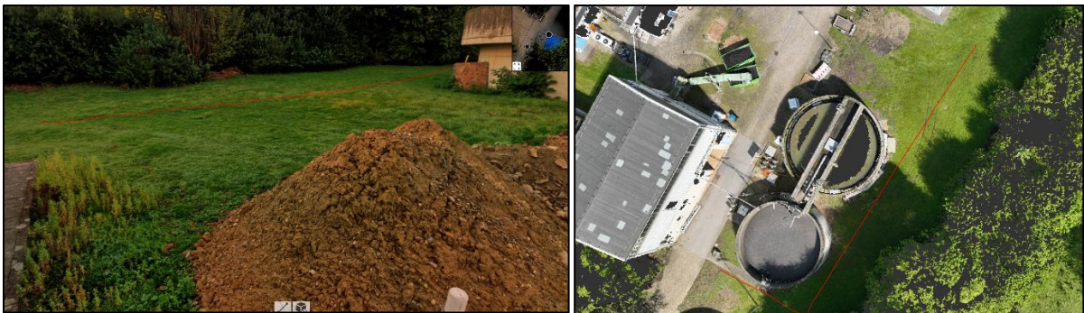
Abbildung 119: Trasse Kabelgraben von K6 zu K10
