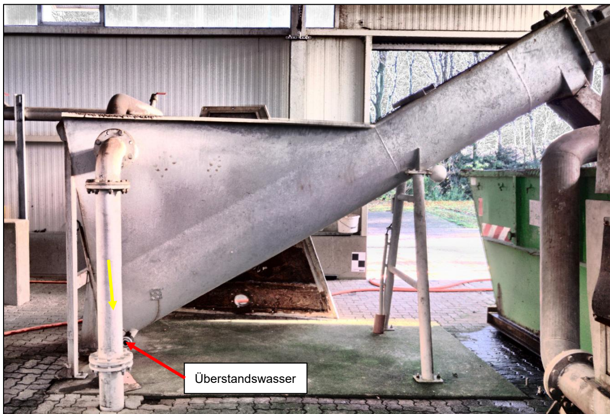
Abbildung 23: Doppel-Längsräumer und Sandklassierer
