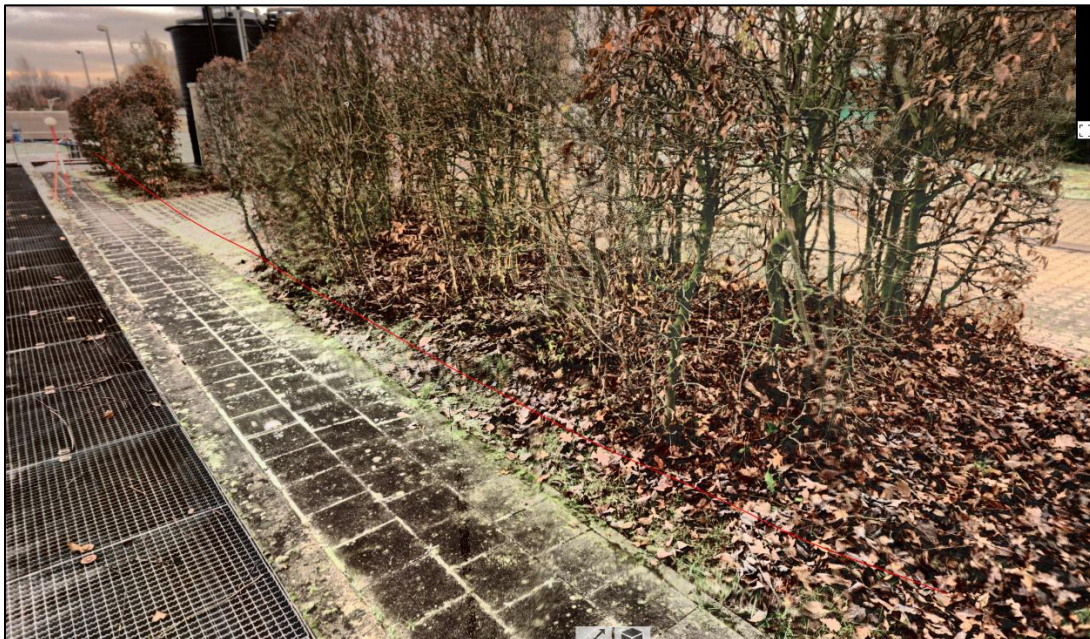
Abbildung 122: Trasse Kabelgraben von der Rechenhalle zu Schacht K13
