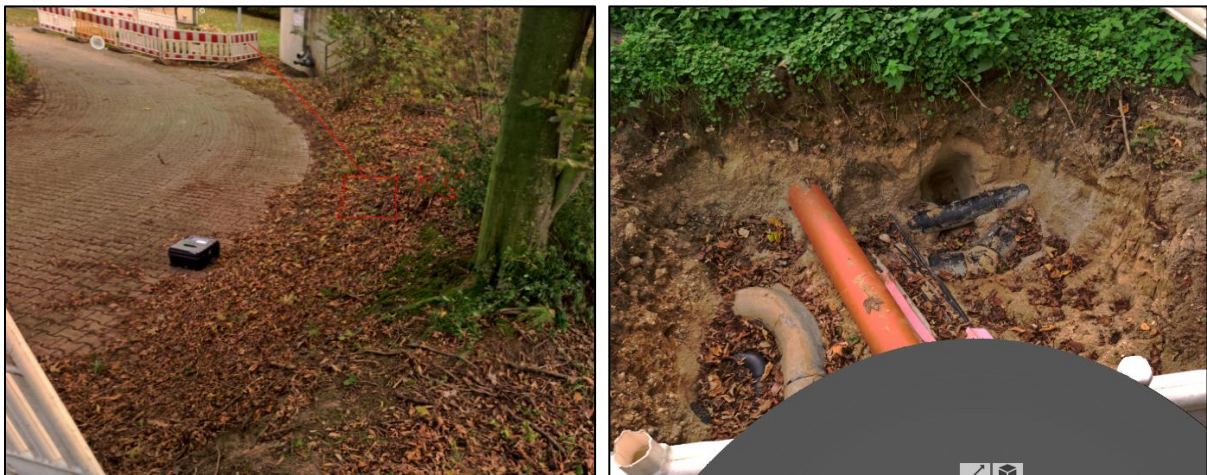
Abbildung 117: Trasse Kabelgraben von K5 zu K6 und Suchschachtung
