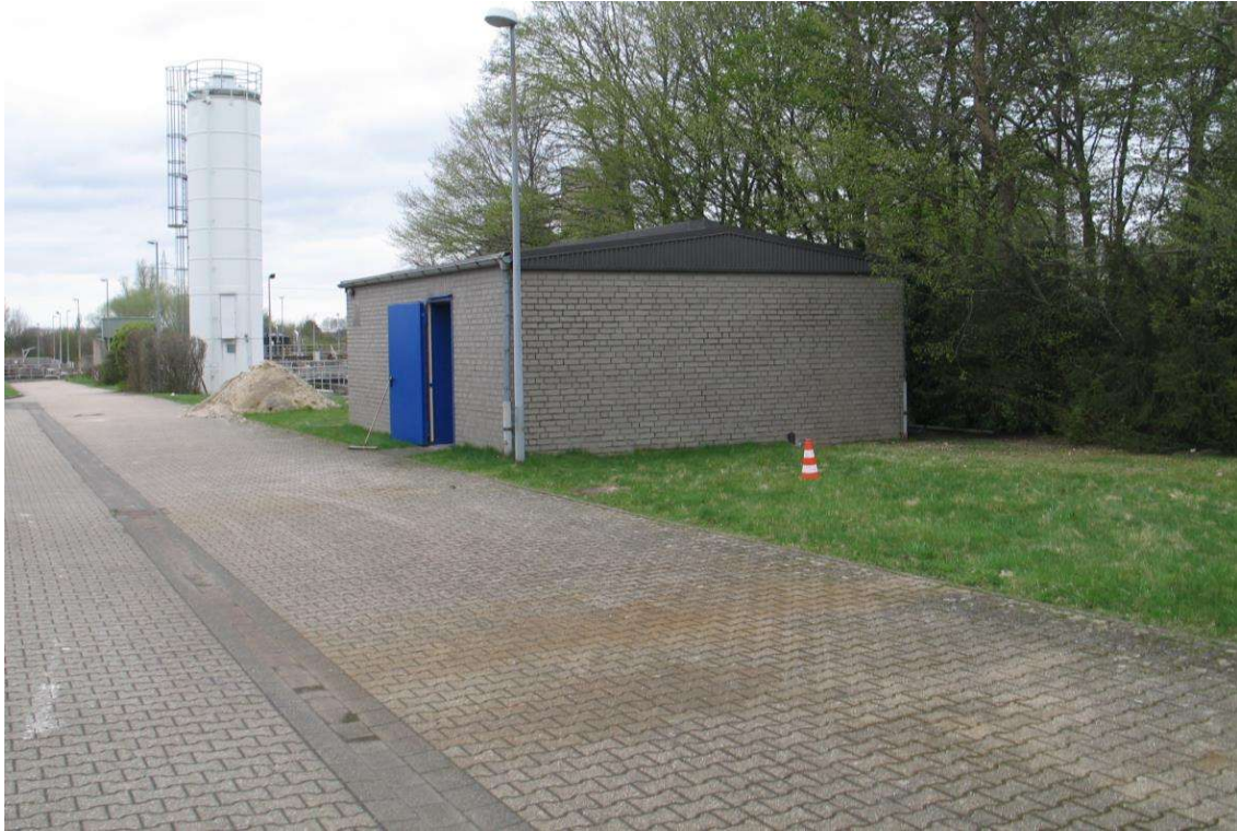
Bild 1.4: Bauplatz neben dem vorhandenen Messhaus
