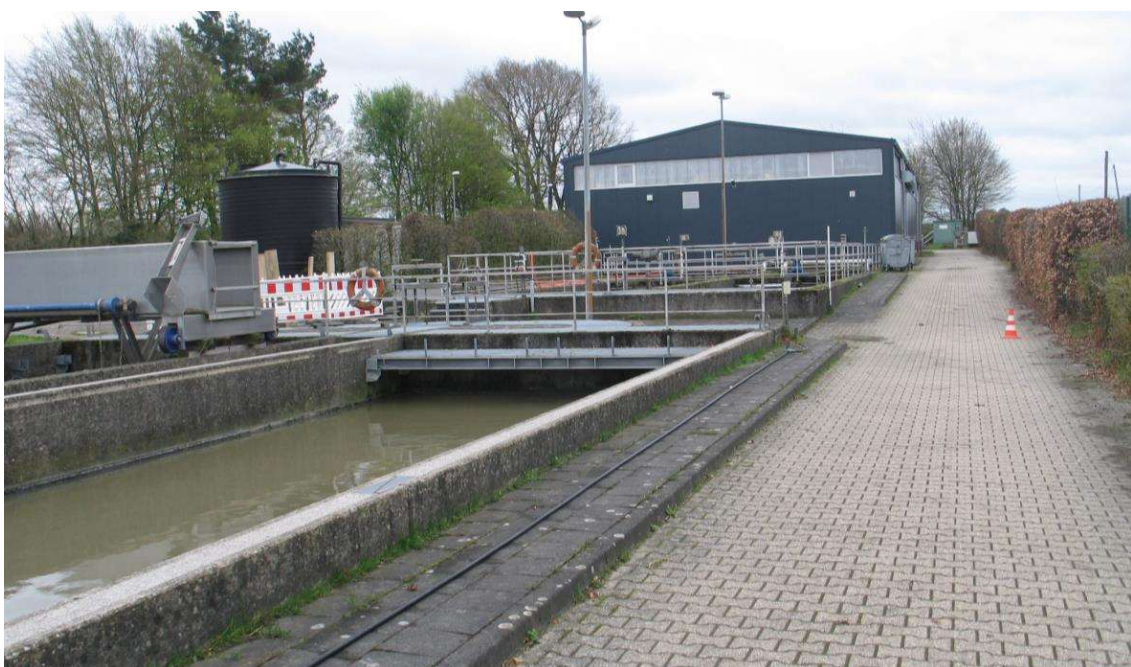
Bild 1.5: Bauplatz für den geplanten Schieberschacht
