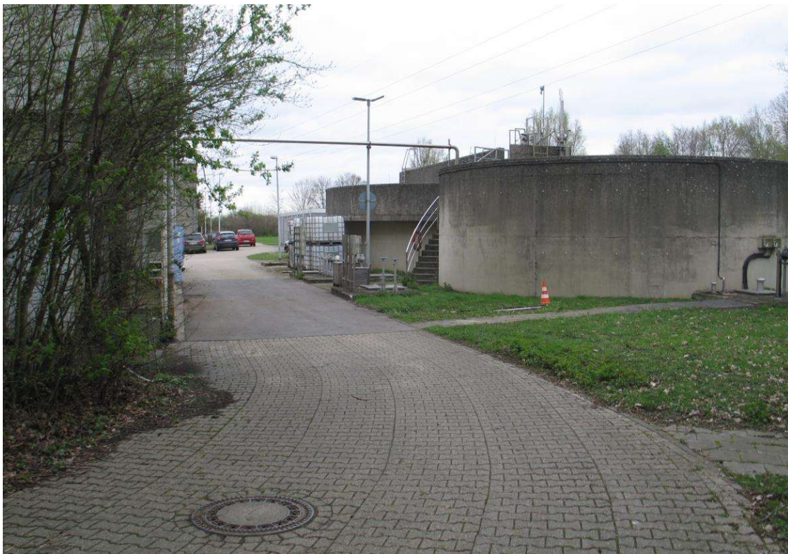
Bild 1.1: vorhandener Nacheindicker östlich der MSE
