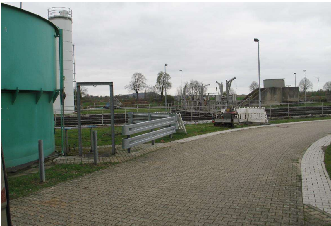
Bild 1.3: Bauplatz für den geplanten MID-Schacht
