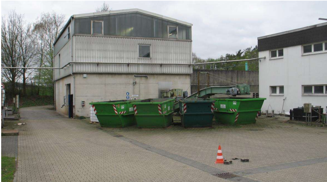
Bild 1.2: vorhandene Containeranlage nördlich der MSE
