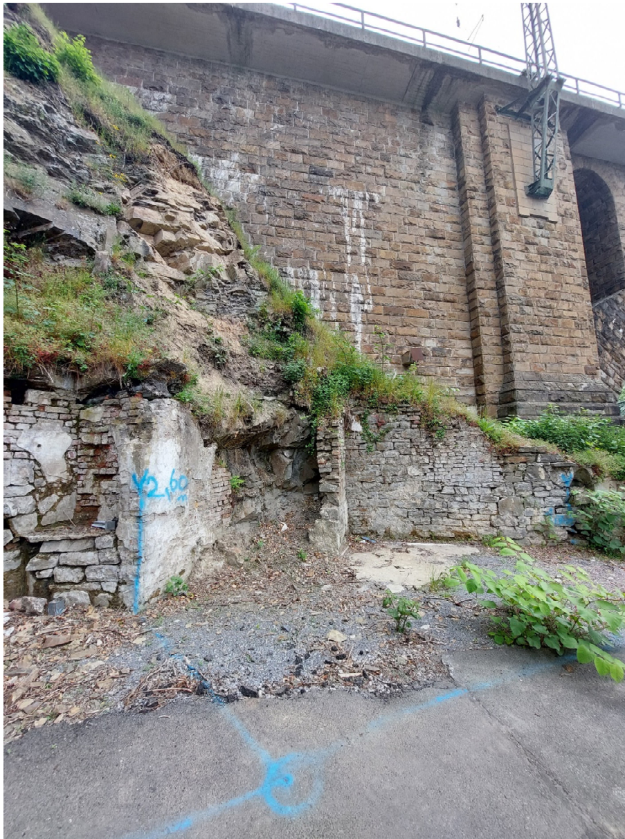
Bild 5: Ansicht Bestandsstützmauer in schlechtem Zustand
