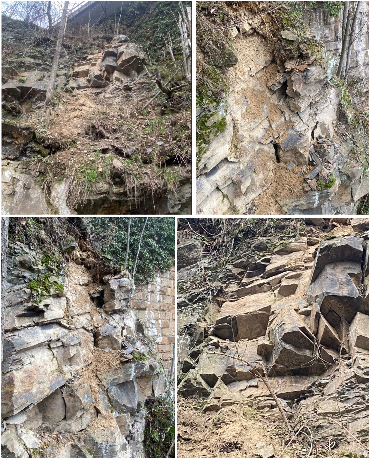
Bild 9: klüftige und lose Felsteile
