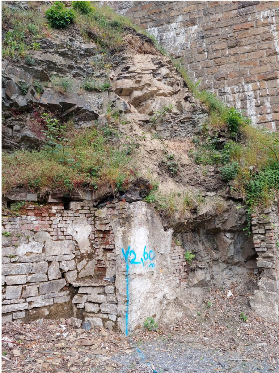
Bild 6: Bestand Stützmauer in schlechtem Zustand, Ausbruchbereich Felsböschung
