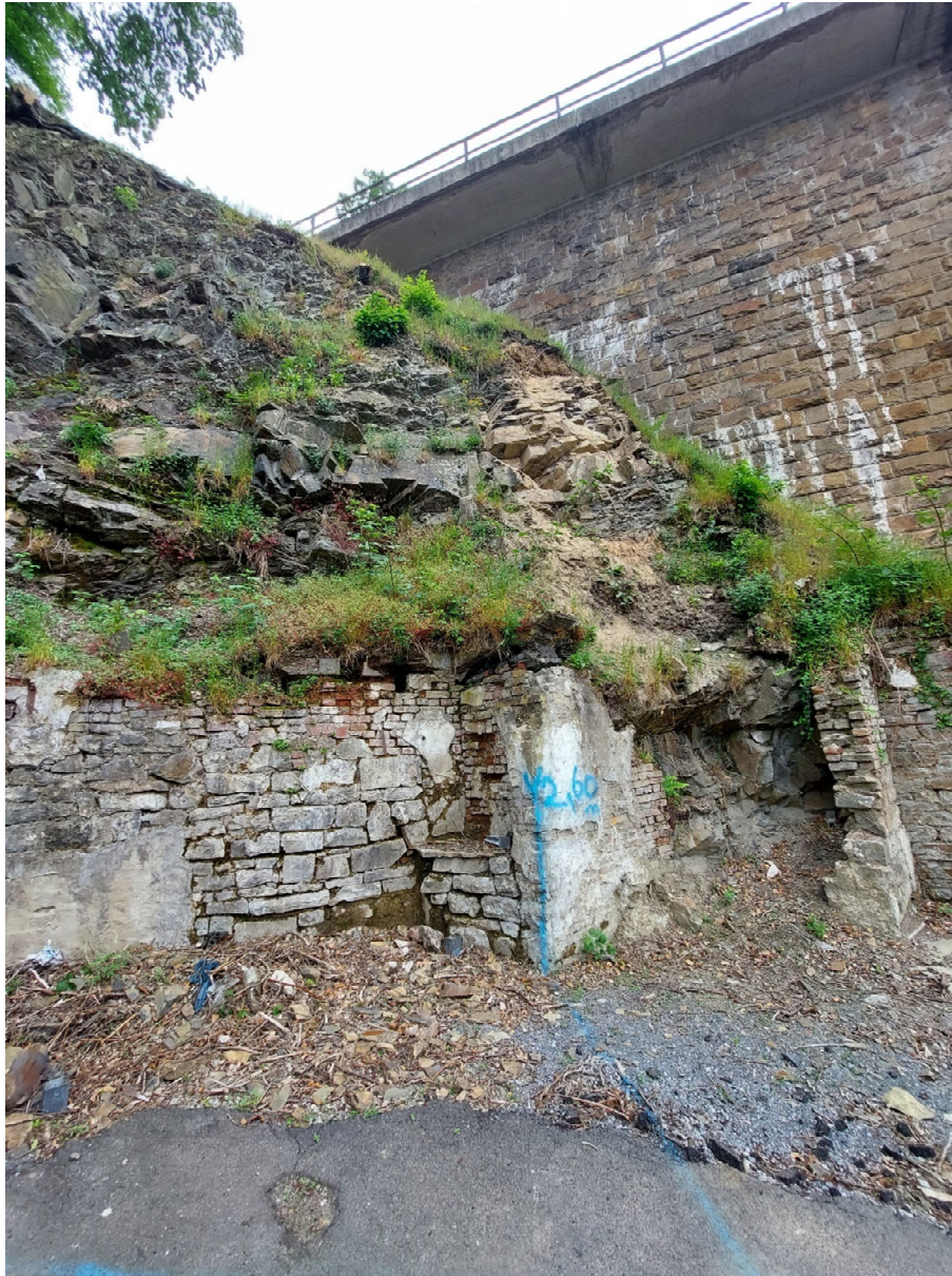
Bild 3: Ansicht Bestand Stützmauer in schlechtem Zustand
