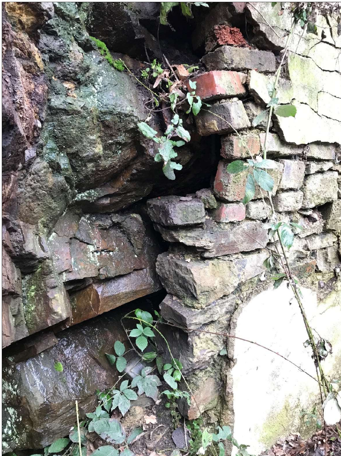
Abbildung 9 Fehlender Kraftschluss Stützmauer/Gebirge hinter der Garage auf dem S' Nachbargrundstück (14.02.2024)
