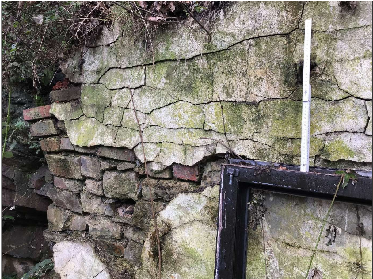
Abbildung 7 Risse in der Verputzung der Stützmauer, S´ Bereich (14.02.2024); Höhe des Maßstabs 40 cm
