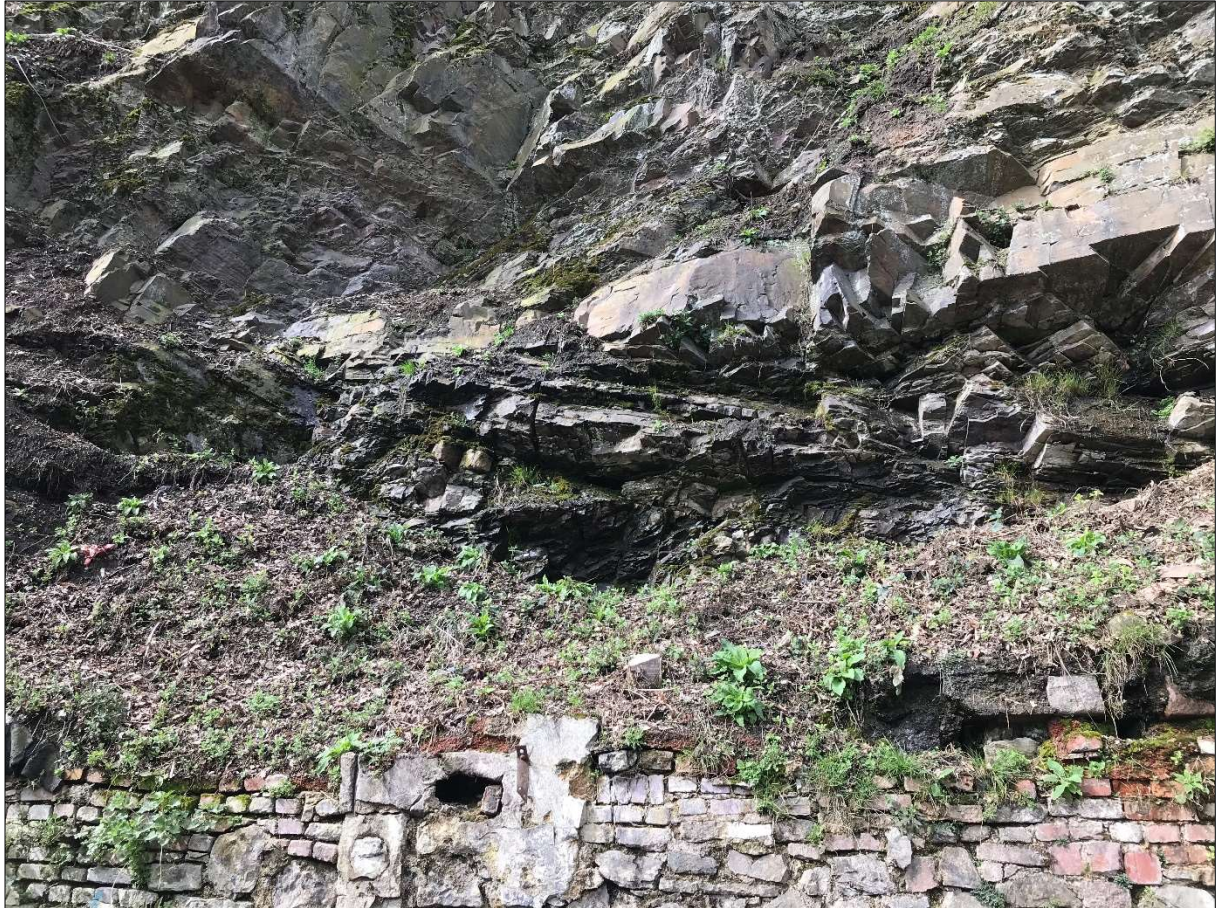
Abbildung 5 Vernässter Bereich in inkompetenteren, tonschieferbetonten Partien oberhalb der Stützmauer (14.03.2024)
