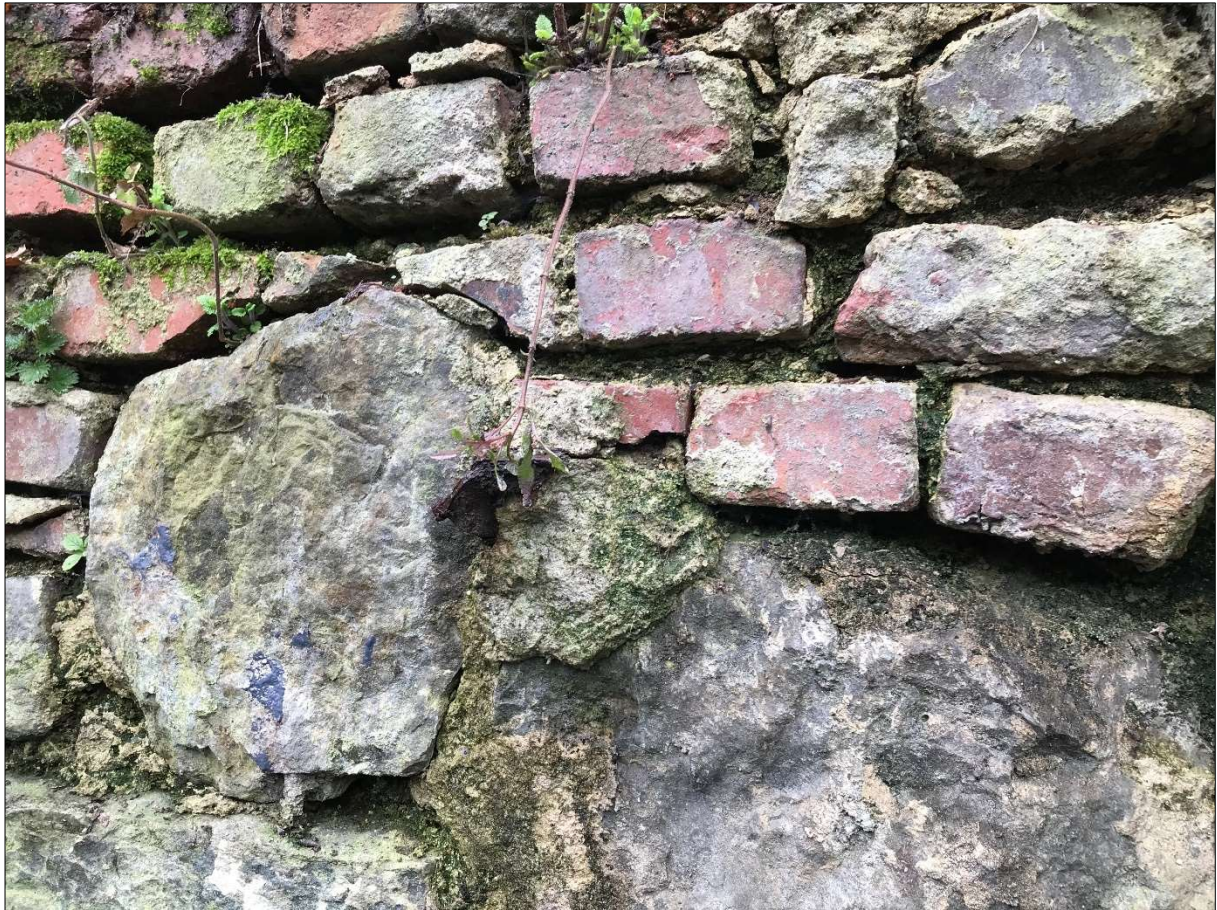
Abbildung 8 Fehlende/erodierte Verfugung des Ziegel- und Natursteinmauerwerks der Stützmauer (14.02.2024)
