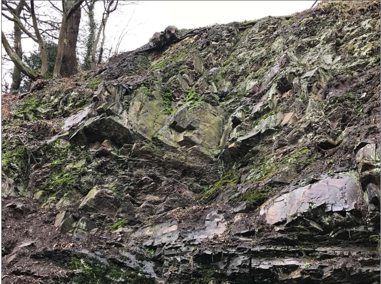
Abbildung 2 Überhängende Schichtpakete und alte Ausbruchbereiche im oberen, S' Teil der Böschung (14.02.2024)
