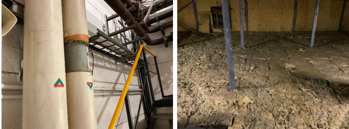
Exempl. Darstellung, BT III Elsa-Halle/Dachzwischenraum Experimentierhalle
