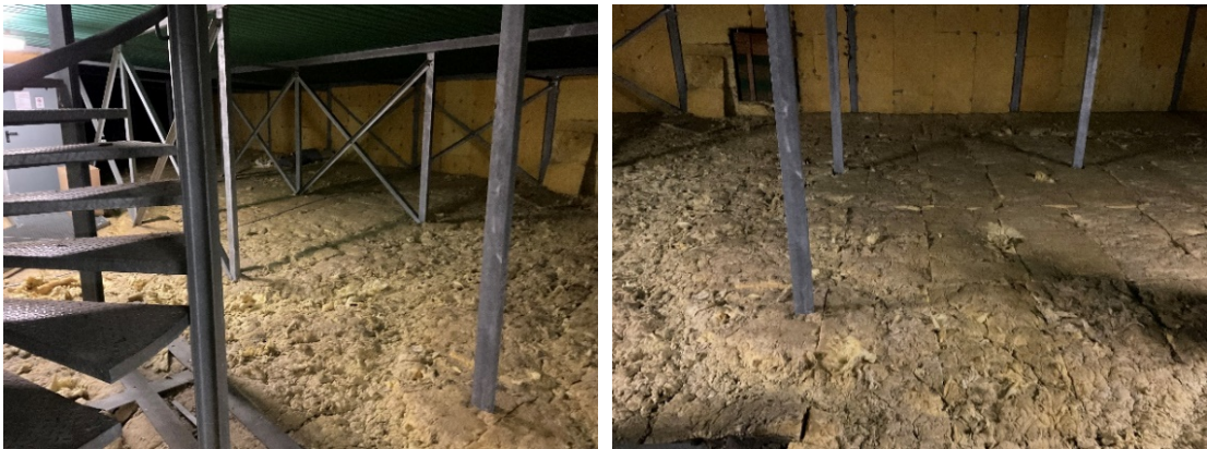
Exempl. Darstellung – Blick auf den ehemaligen Flachdachbereich
