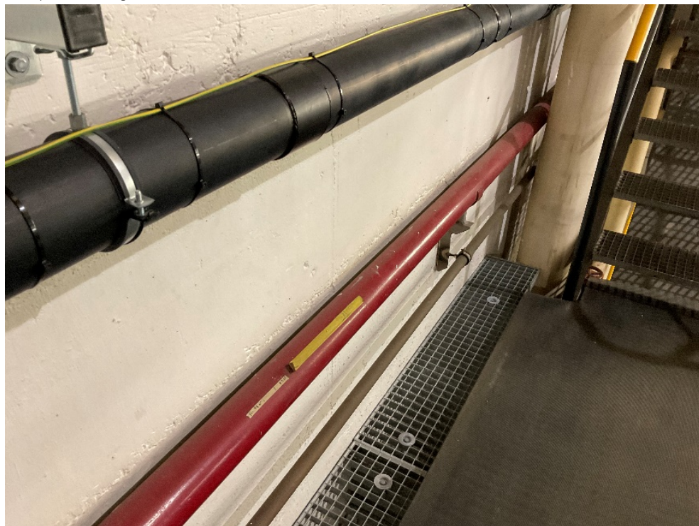
Exempl. Darstellung – aufgrund der geringen PCB-Gehalte verm. sekundär-kontaminiert
