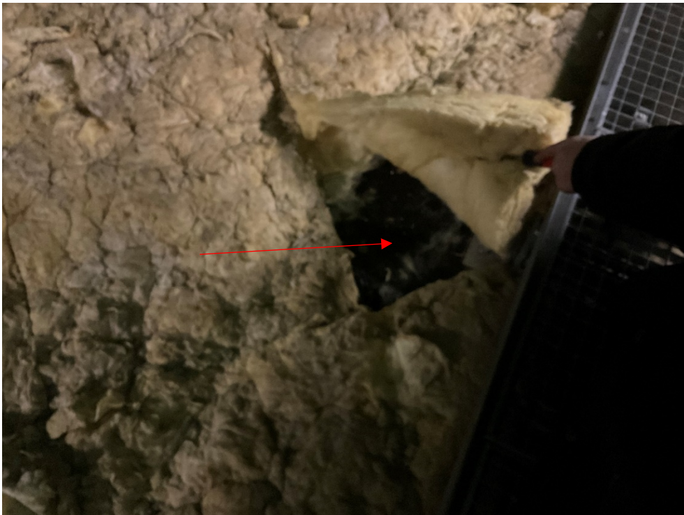
Exempl. Darstellung – Unterhalb der Dämmschicht findet sich die ehemalige bituminöse Abdichtungskonstruktion
