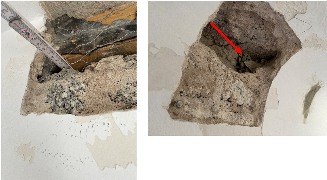
Abbildung 23: Innenwand mit Vorsatzschale aus Bimsbeton und Papierfüllung (Raum 1.003)
