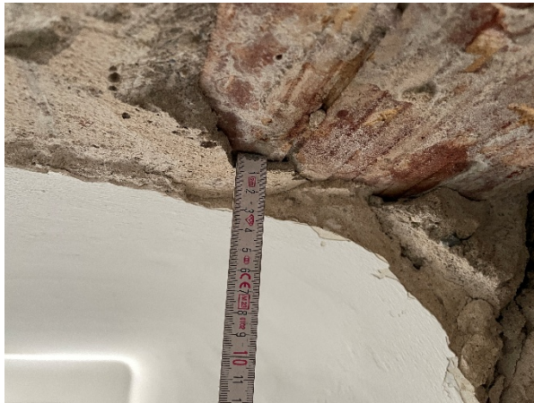
Abbildung 25: Geschossdecken (Raum 2.016 und Raum 1.003)
