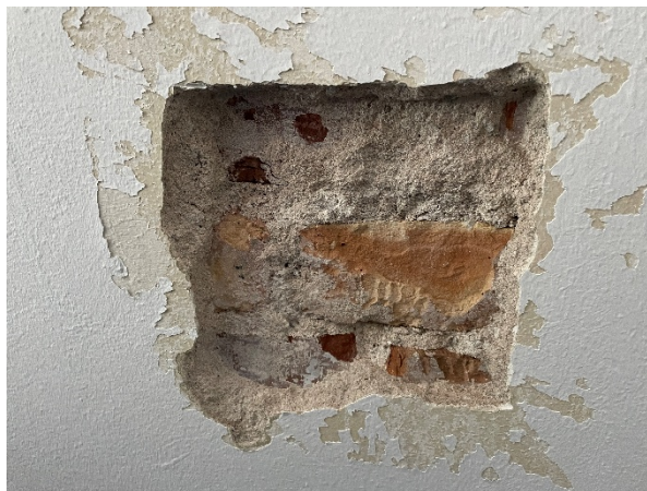
Abbildung 24: Innenwand aus Ziegelmauerwerk (Raum 2.016)
