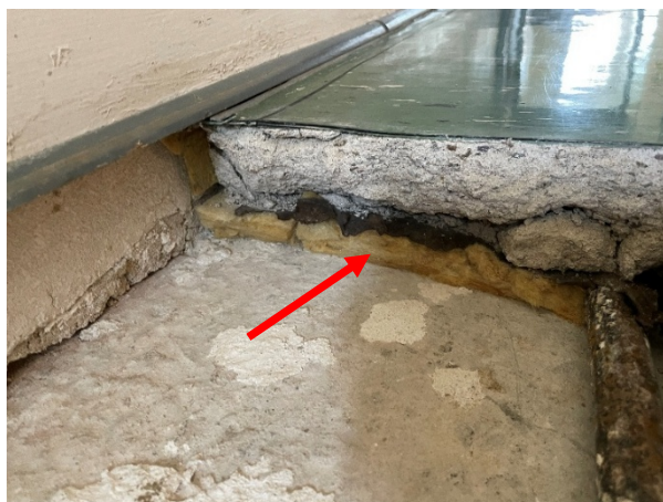
Abbildung 36: Trittschalldämmung unterhalb des Estrichs
