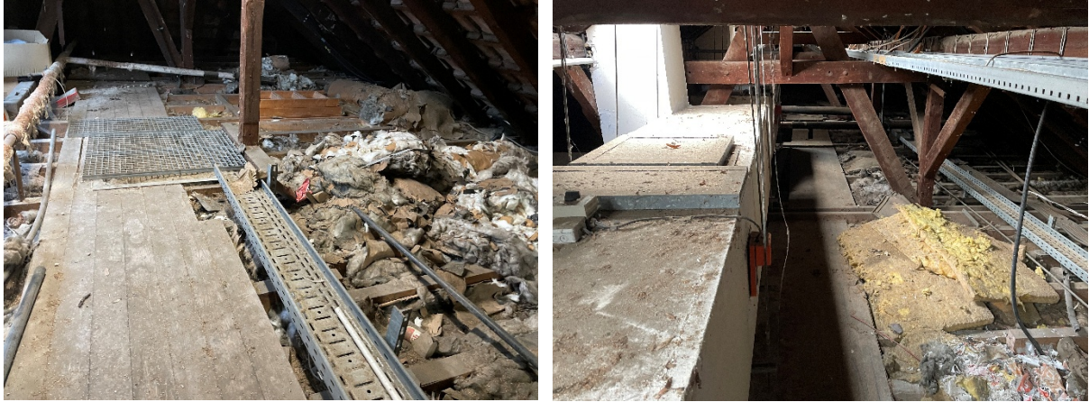
Abbildung 43: KMF-gedämmte Hohlbalkendecke, Dachboden
