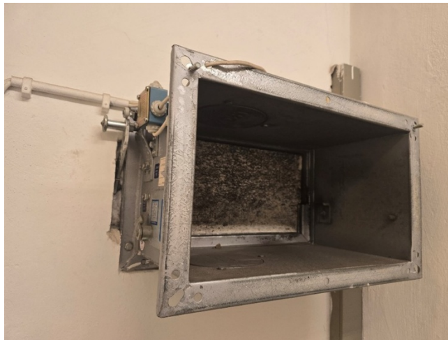
Abbildung 33: Überstromklappe Raum 2.018
