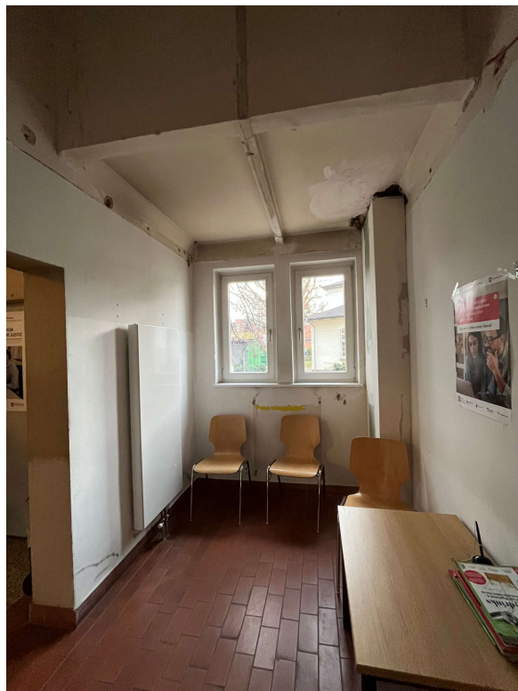
EG 1.5-1.6 Blick Richtung Außenwand
