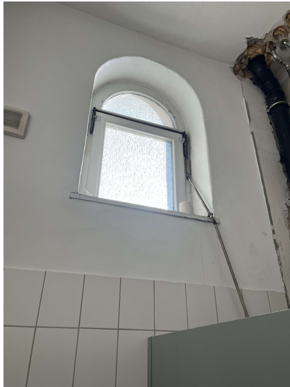
1. OG WC 102, Fenster Bestand
