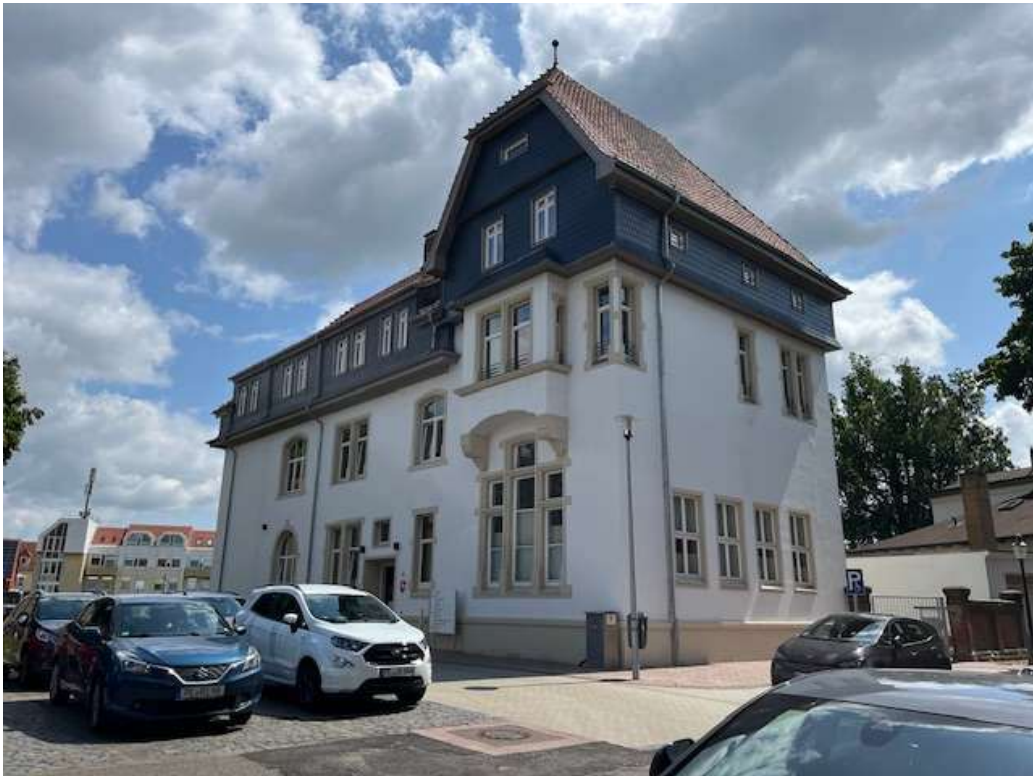
Außenfassade Northwest Haus 6
