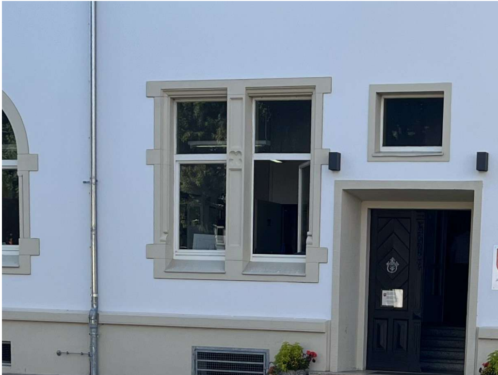
Außenfassade Südost, Blick auf Bestandsfenster EG Wache 24.2
