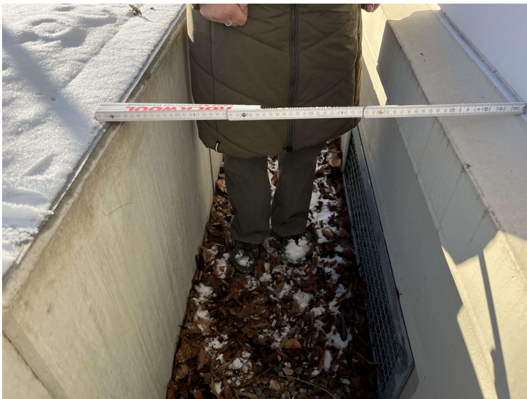
Außenfassade Südost, Abstand zum Podest des barrierefreien Zugangs
