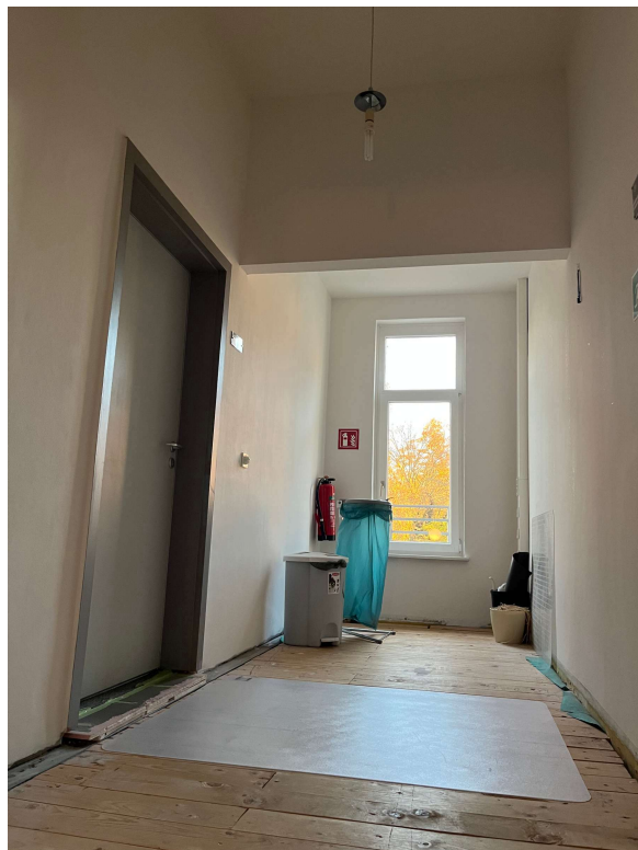
1. OG Flur 104, Blick Richtung Außenwand
