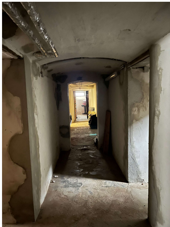
KG Flur 001, Blick Richtung Flur 001.2
