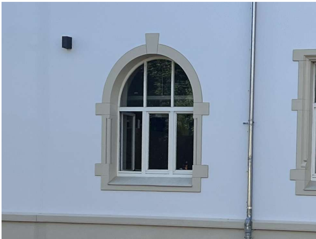
Außenfassade Südost, Blick auf Bestandsfenster EG Wache 24.3
