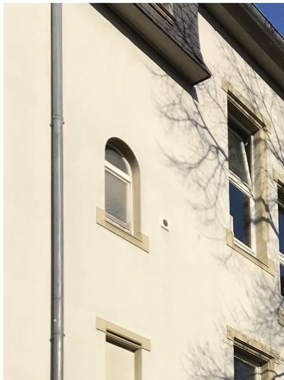
Außenfassade Südost, Blick auf Bestandsfenster WC 102
