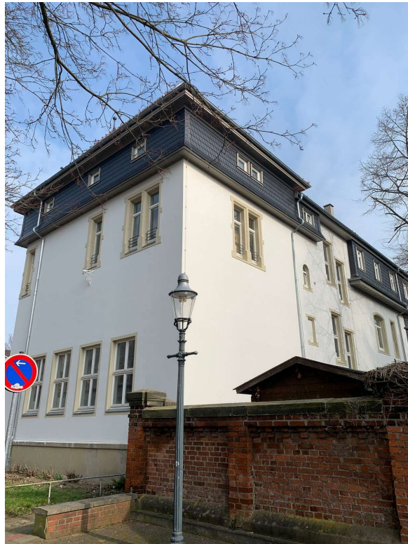
Außenfassade Gebäudeecke Süd
