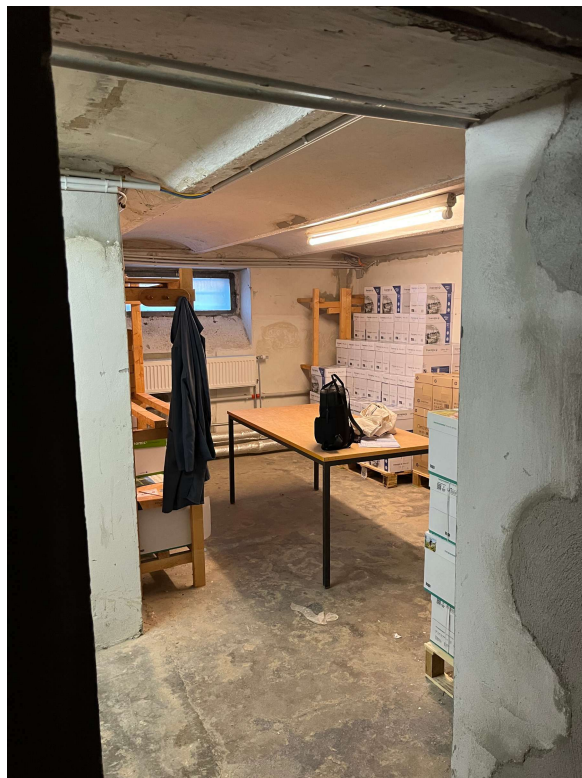
KG Lager 004, Blick Richtung Außenwand
