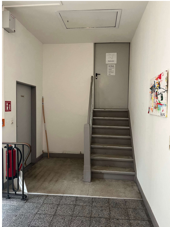
2.OG Flur 201, Blick Richtung T 201.2
