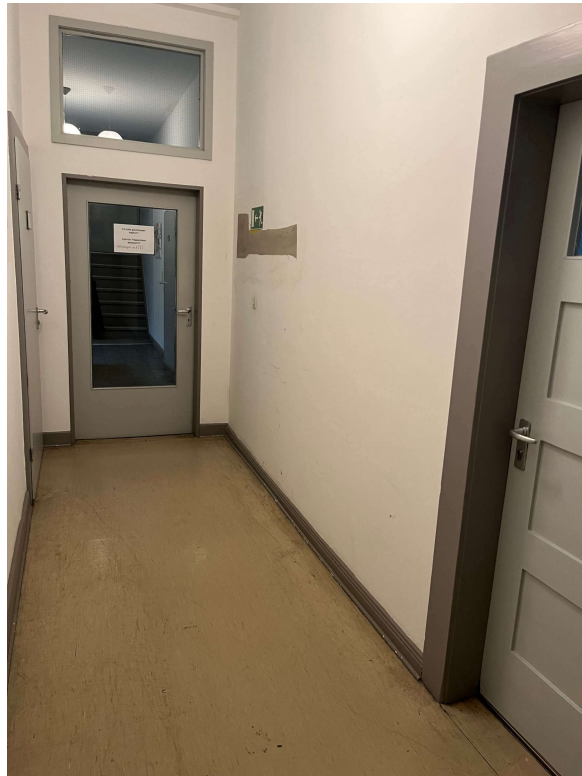
2.OG Flur 201a, Blick Richtung T 201.1
