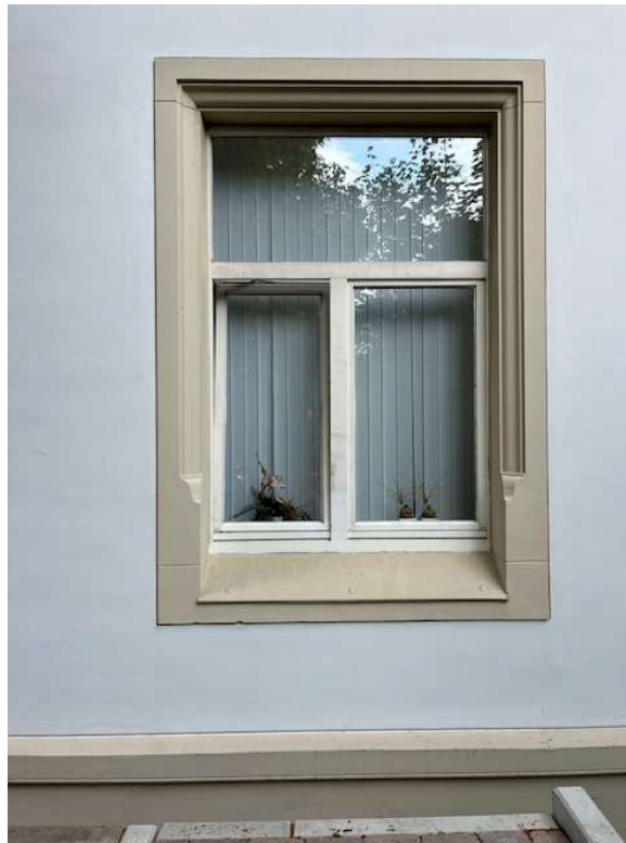
Außenfassade Südost, Bestandsfenster zum barrierefreien Zugang
