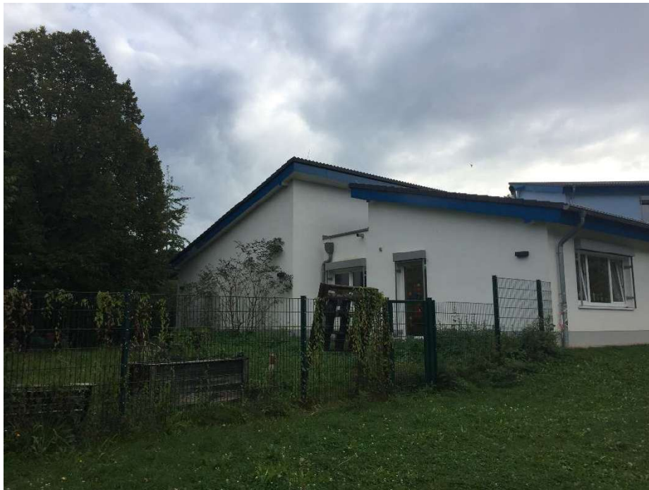
Best. Anbau Nord (Nordseite / Seite geplante Erweiterung)
