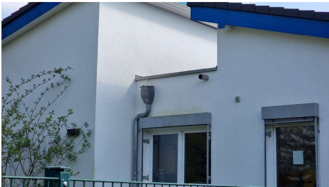
Entwässerung und Notentwässerung best. Anbau Nord
