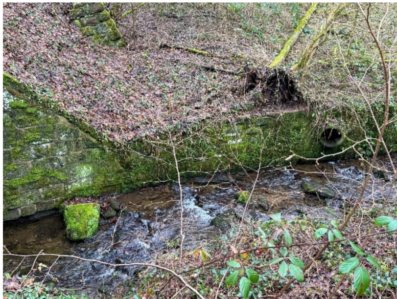
Bild 22 Laubach südlicher Auslauf mit anschließender Stützwand und Rohrauslauf
