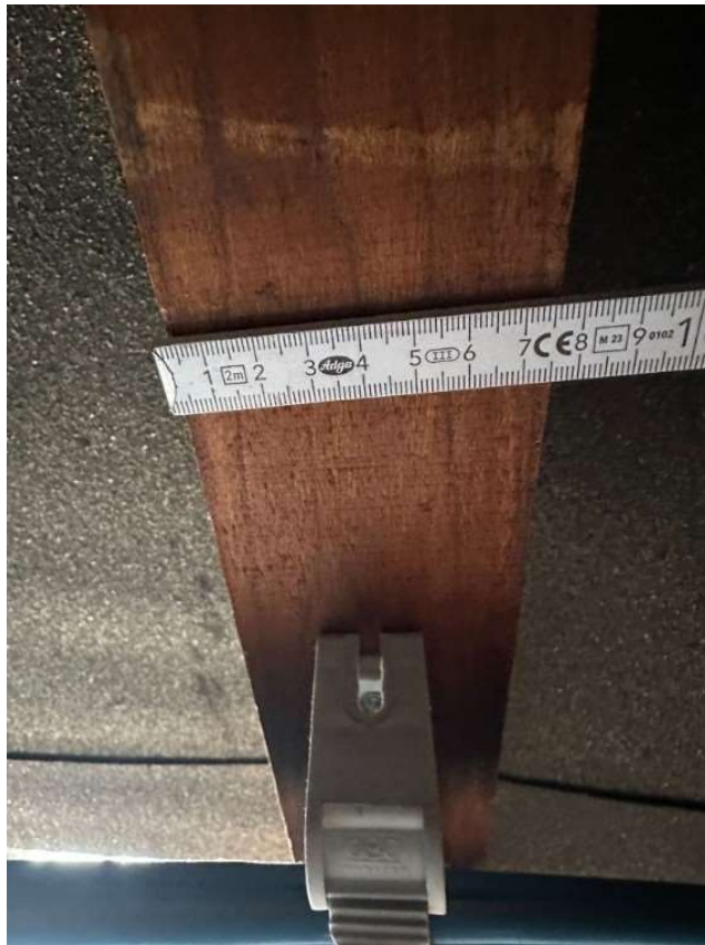
Abbildung 6: Sparrenbreite
