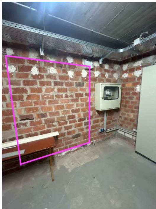
Abbildung 3: Installationszone der Systemkomponenten (Wechselrichter und Energiespeicher)
