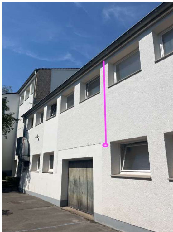
Abbildung 10: Kabelführung DC außen
