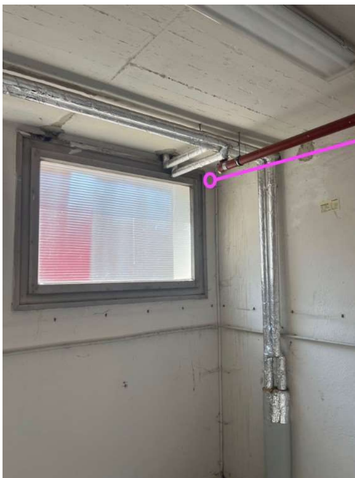
Abbildung 11: Kabeldurchführung DC innen
