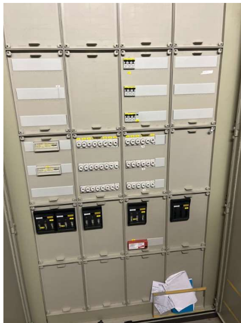
Abbildung 1: Niederspannungshauptverteilung
