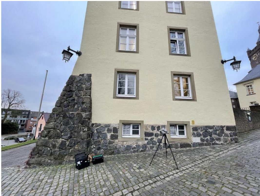
Abbildung 1: Außenfoto, Amtsgericht Kleve, Nebengebäude, Kellerraum E. Die sich im Natursteinsockel befindlichen zwei gittergesicherten Fenster gehören zum Kellerraum E für die Aktenlagerung. Der Haupteingang befindet sich auf der rechten Gebäudeseite.
