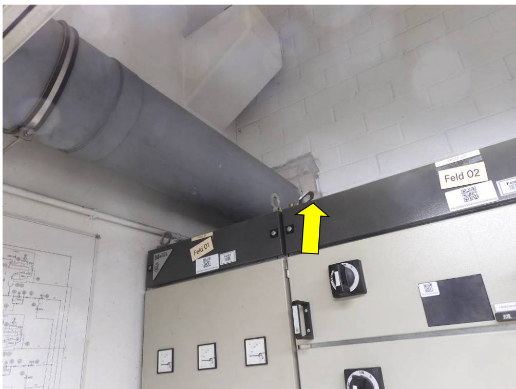
Foto 6: w.v. Übergang zum Raum NSUV PWPW
