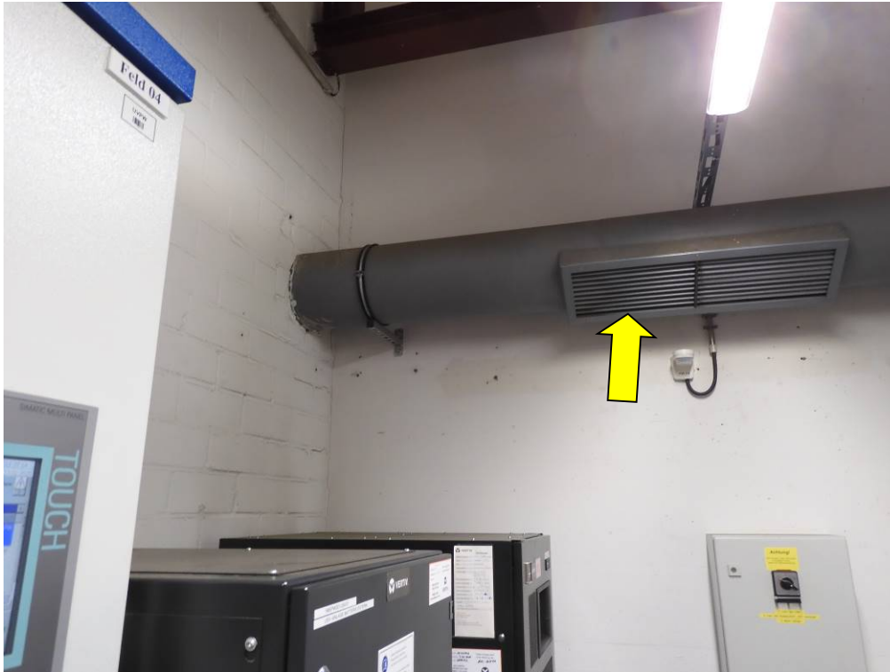
Foto 1: Zuluffleitung Raum NSUV PWPW, DN 300, Lüftergitter
