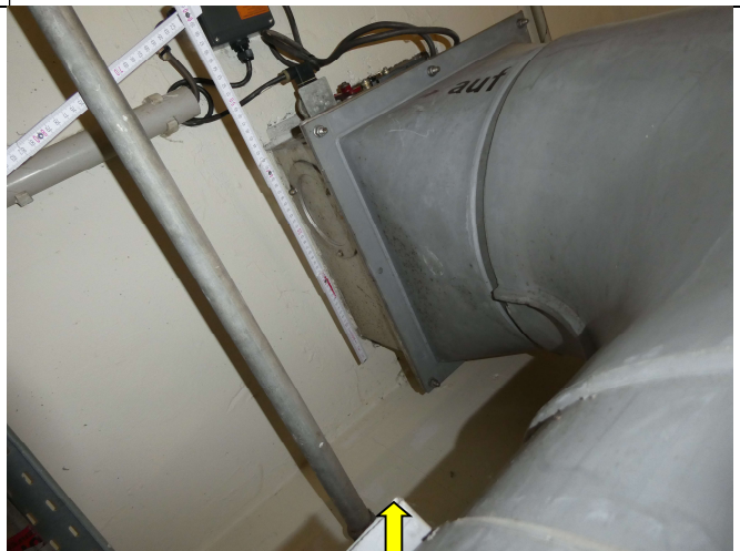
Bild 8: Brandschutzklappe Unterseite
