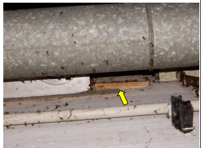
Bild 13: Brandschutzklappe , Holzbrett von unten gesehen
