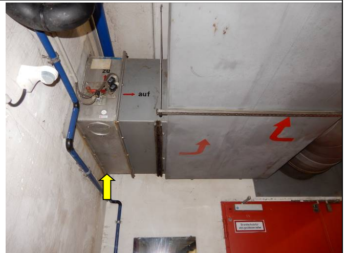
Bild 16: Brandschutzklappe Lage in der Halle VK Süd
