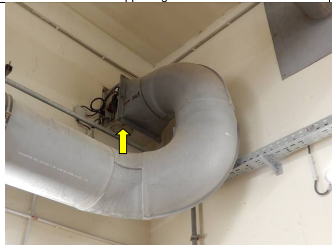
Bild 5: Brandschutzklappe Lage in der Rechenhalle Süd
