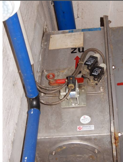
Bild 18: Brandschutzklappe
