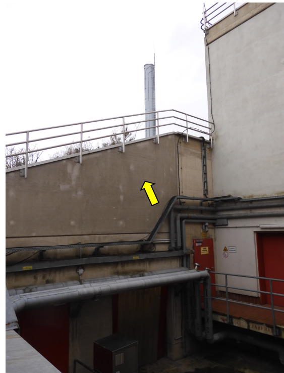
Bild 14: Erdreich oberhalb Wand Brandschutzklappe
