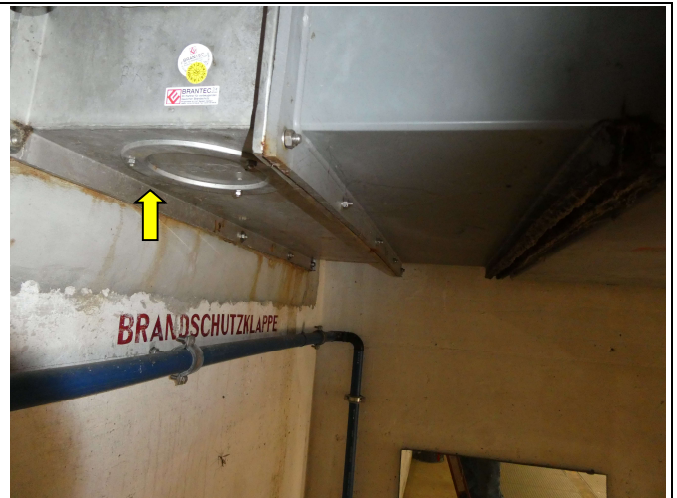
Bild 20: Brandschutzklappe Revisionsöffnung
