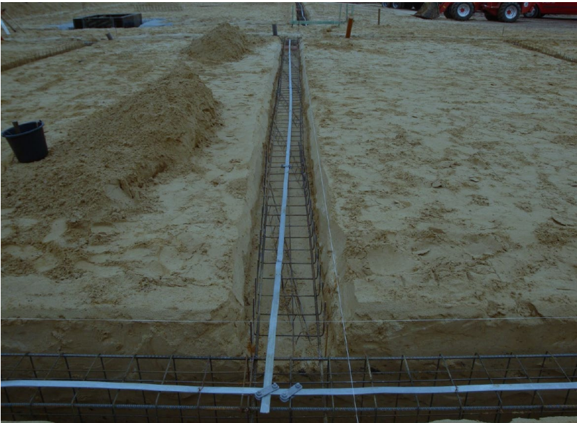
Beispiel eines Fundamenterders im Streifenfundament
