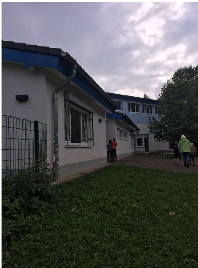
Best. Anbau Nord (Westseite)
