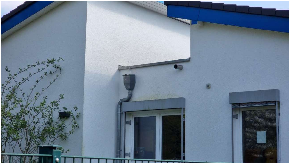
Entwässerung und Notentwässerung best. Anbau Nord
