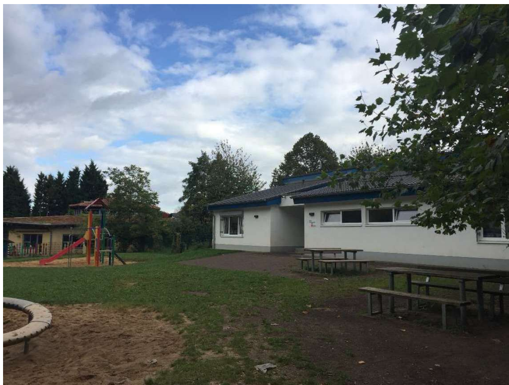
Best. Anbau Nord (Westseite)
