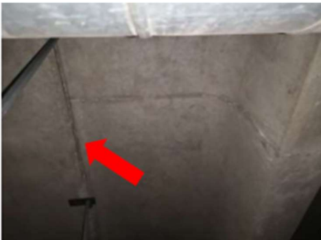
Dichtschnur im Deckenbereich zwischen Betonelementen
