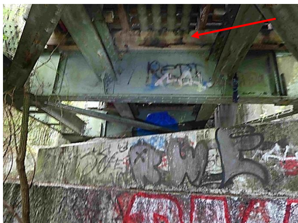
Foto 15: westliches Widerlager; auszutauschender Querbalken aus Holz (Pfeil)
