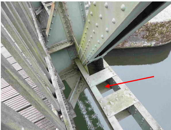
Foto 11: Stahlgerüst (unten) mit einseitig offener Nische ...
