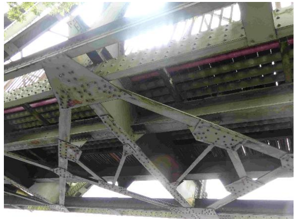
Foto 8: unter der Brücke verlaufen Rohre mit Leitungen; Abstände zwischen auszutauschenden Holzdielen erkennbar
