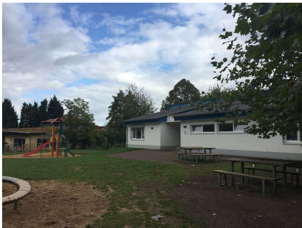
Best. Anbau Nord (Westseite)
