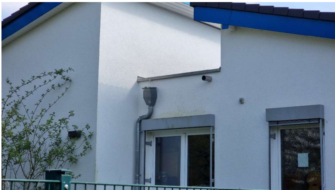
Entwässerung und Notentwässerung best. Anbau Nord
