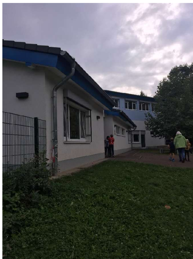
Best. Anbau Nord (Westseite)
