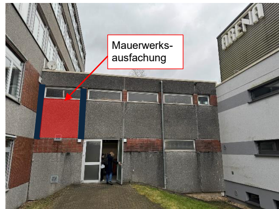
Abbildung 34: MW-Ausfachung (südl.)
