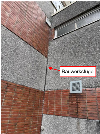
Abbildung 38: Verbindungsgang Fuge
