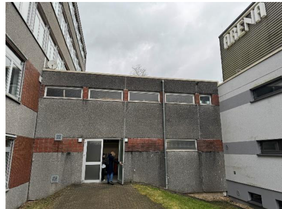
Abbildung 7: Verbindungsgang (v. Süd)
