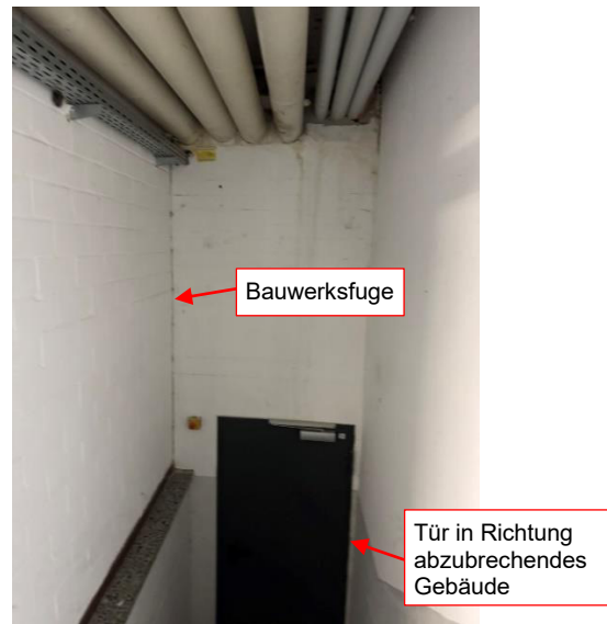
Abbildung 39: Verbindungsgang Fuge
