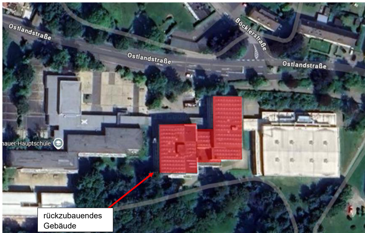
Abbildung 1: Übersicht des rückzubauenden Gebäudes
