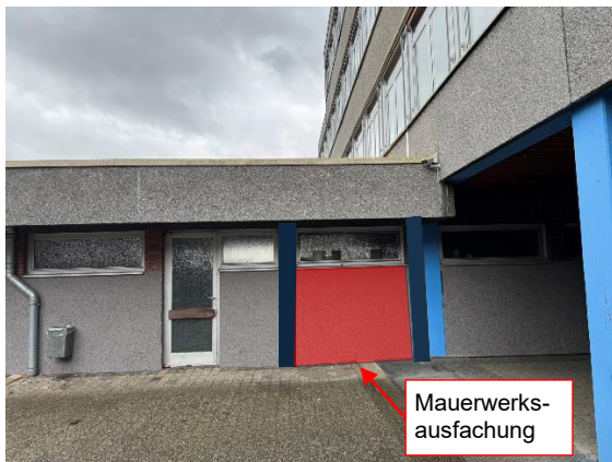
Abbildung 33: MW-Ausfachung (nördl.)
