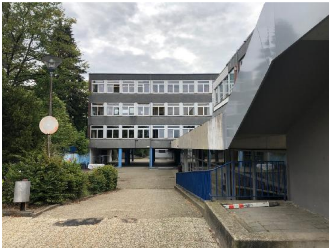
Abzureißender Erweiterungsbau der KAH, Westfassade
