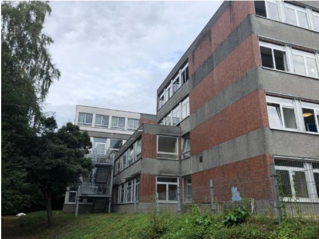
Abzureißender Erweiterungsbau der KAH, Südfassade
