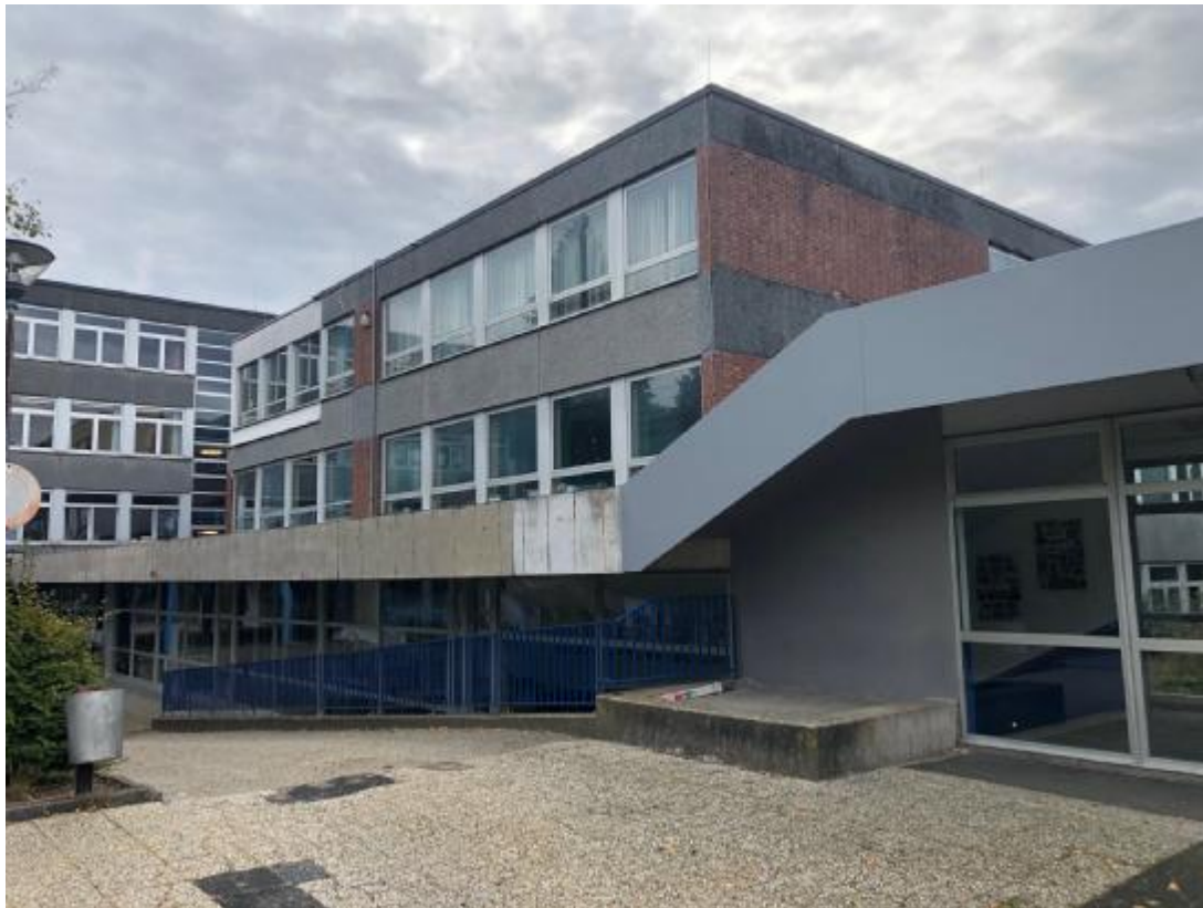
Abzureißender Erweiterungsbau der KAH, Nordfassade
