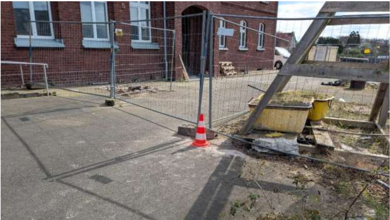
Abbildung 1: Blick in Richtung Südosten auf den Ansatzpunkt RKS 1.
