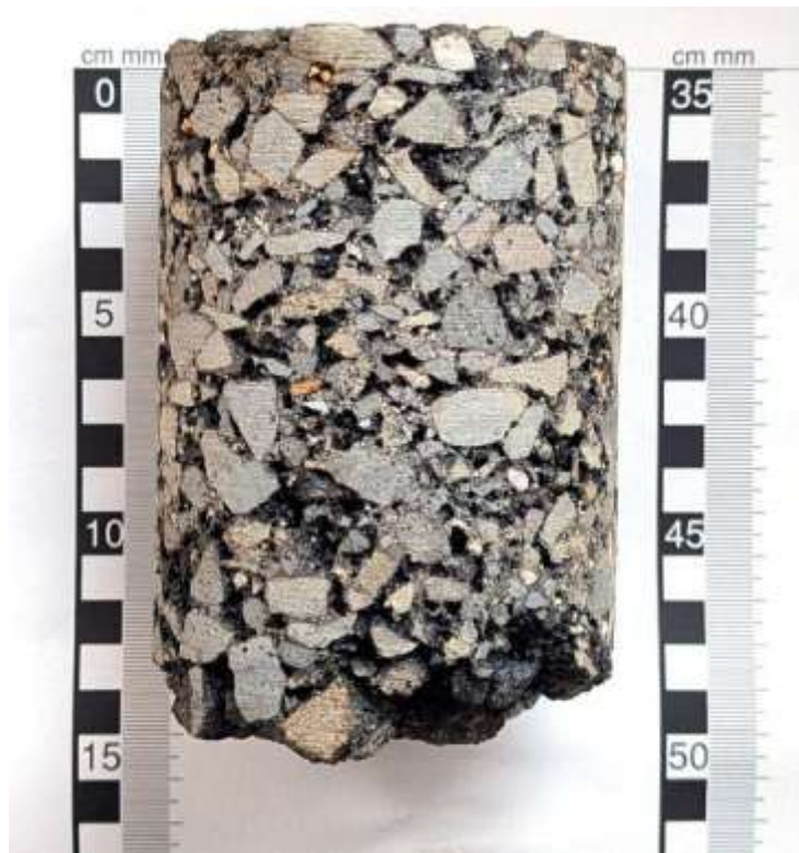
Abbildung 5: Asphaltkern von Ansatzpunkt RKS 3.
