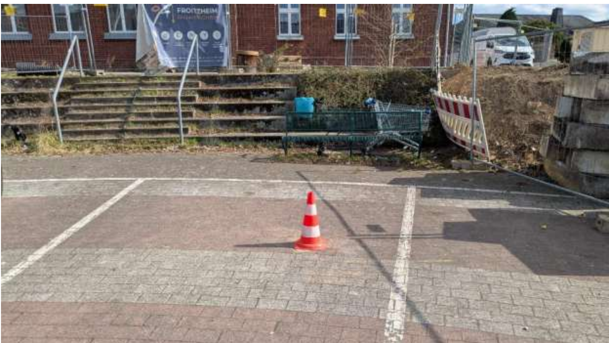
Abbildung 6: Blick in Richtung Südosten auf den Ansatzpunkt RKS 4.
